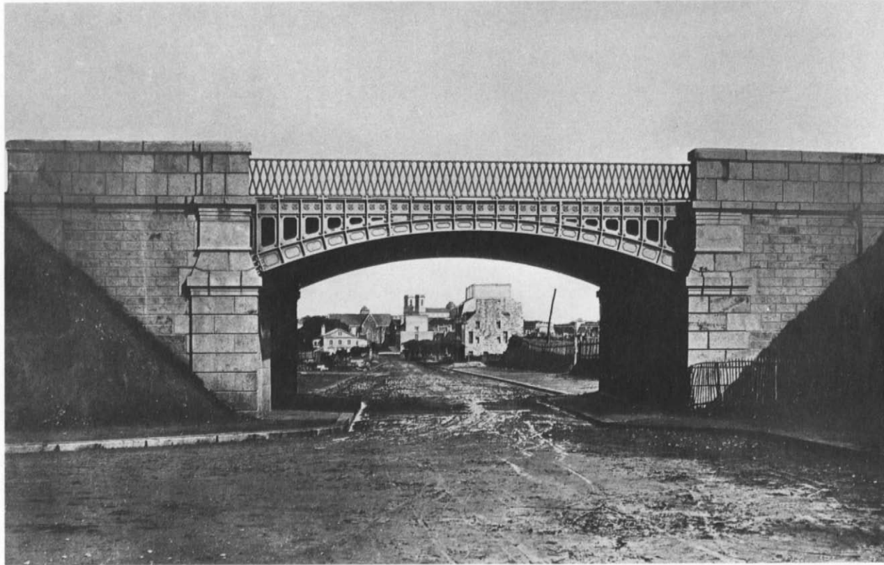
Fig. 71. Cast-Iron Overpass, Chemin de Fer de Rennes à Brest, Saint-Brieuc , 1863. Albumen silver print from glass negative, 28.2 × 43.9 cm (11 1 / 8 × 17 1 / 4 in.). École Nationale des Ponts et Chaussées, Paris
